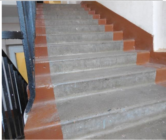
Фото №19 – Пути движения внутри здания (лестницы)
