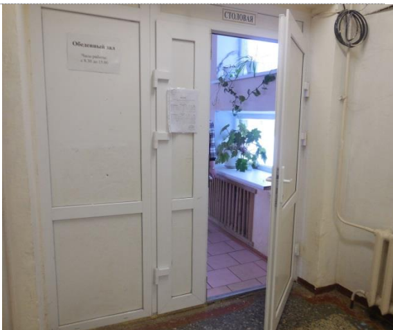
Фото №23 – Пути движения внутри здания (двери)
