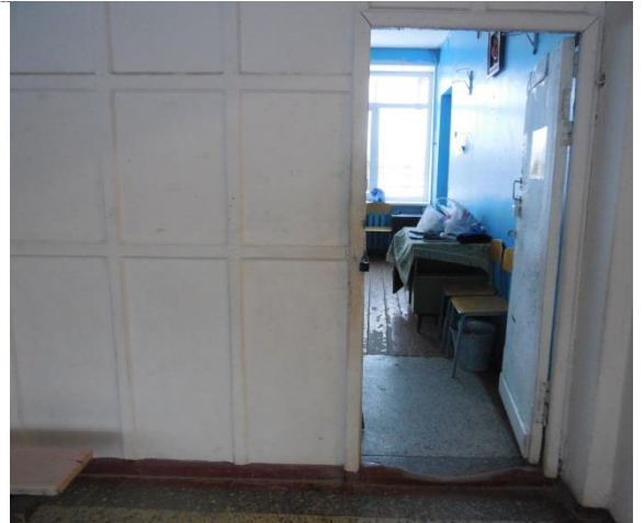
Фото №20 - Пути движения внутри здания (двери)
