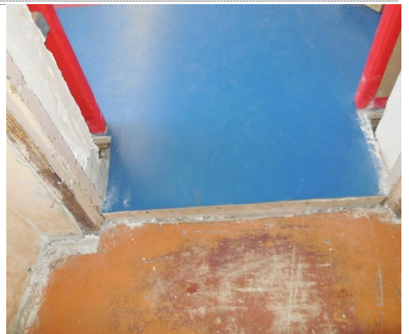
Фото №22 – Пути движения внутри здания (двери)
