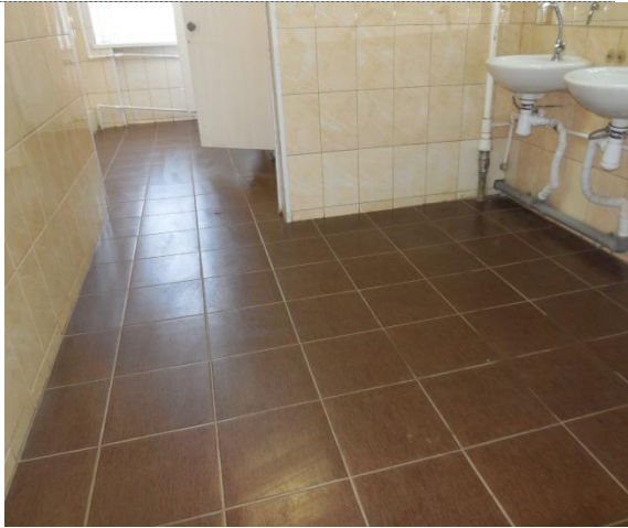
Фото №31 – Санитарно-гигиенические помещения.
