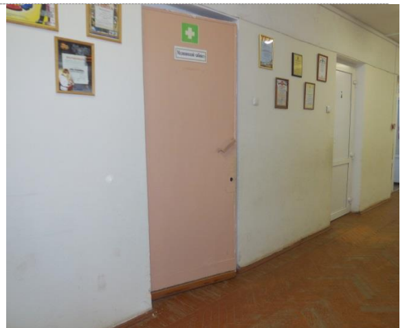
Фото №24 – Пути движения внутри здания (двери)
