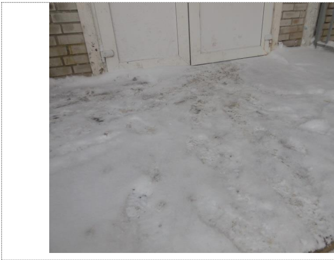
Фото №9 – Входная площадка главного входа
