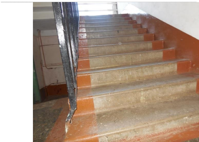
Фото №17 – Пути движения внутри здания (лестницы)
