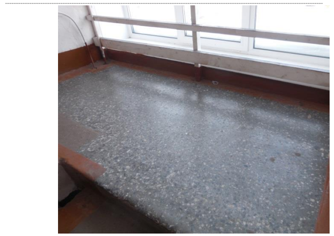
Фото №18 – Пути движения внутри здания (лестницы)
