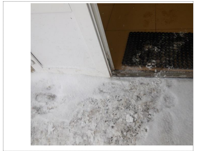
Фото №10 – Наружная входная дверь
