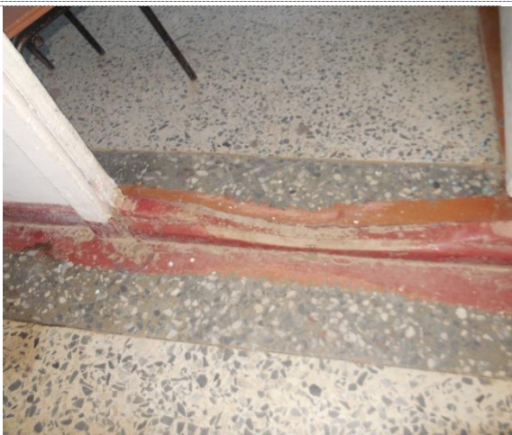
Фото №21– Пути движения внутри здания (двери)
